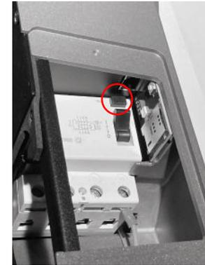
Figure 5 : Bouton de test RCD
