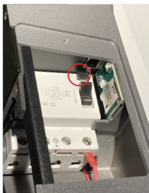
Figure 5 : Bouton de test RCD
